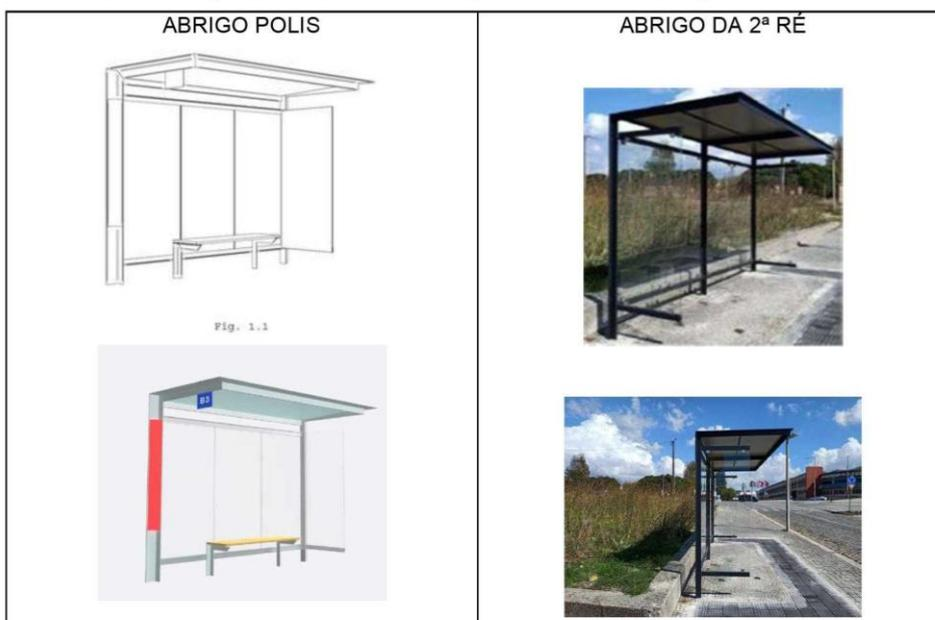
Por seu turno, as semelhanças entre os Abrigos reconduzem-se apenas a dois aspetos visíveis: utilização do mesmo perfil de construção da estrutura em cantoneira e existência de abertura na parte superior e inferior do painel traseiro e lateral.
